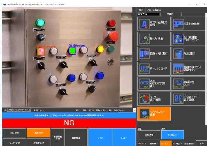
制御盤のランプの ON/OFF の読み取り
